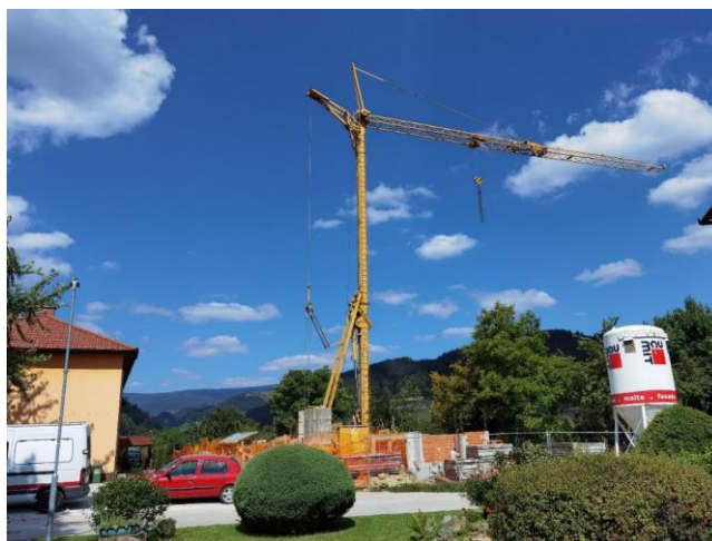
Slika št. 8: Blok v izgradnji
