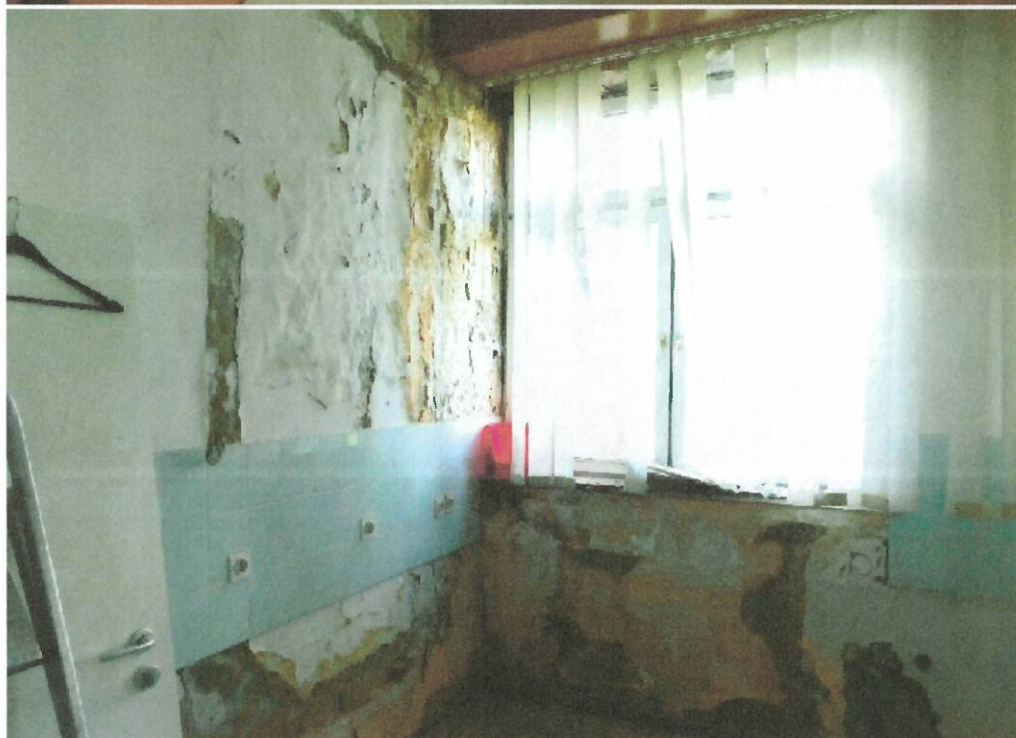
Poškodbe zaradi zamakanja v prostoru za čistila (tolikšen obseg je samo v tem prostoru!)
