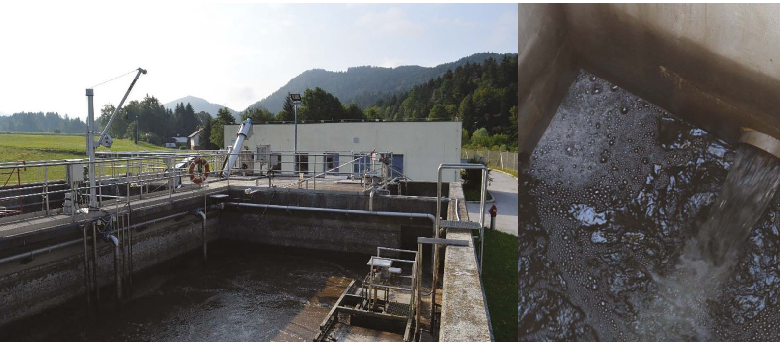
Čistilna naprava Mislinja (levo); izpust iz naprave (desno)
