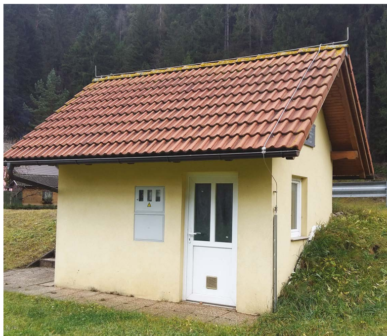
Mala hidroelektrarna v Suhem dolu
