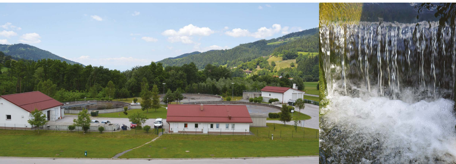
Centralna čistilna naprava Slovenj Gradec (levo); izpust iz naprave (desno)
