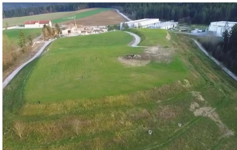
Zaprto odlagališče nevarnih odpadkov Mislinjska Dobrava
