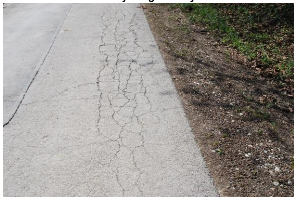
Slika 3: Prikaz obstoječega stanja
