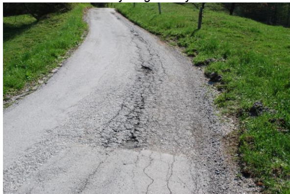
Slika 3: Prikaz obstoječega stanja
