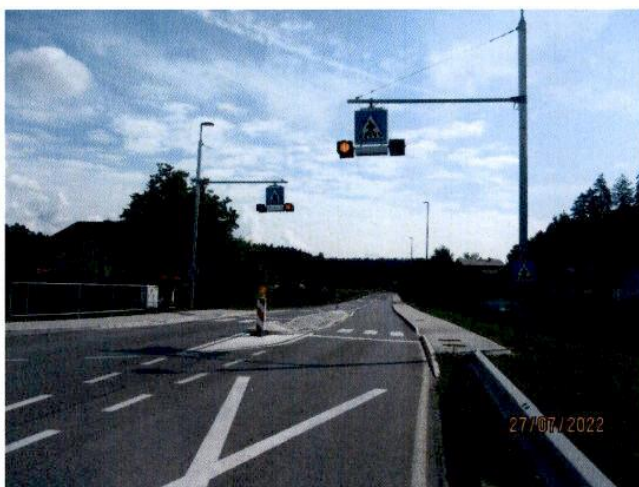
Slika 1: Obravnavani prehod za pešce (pogled v smeri Stranic)
