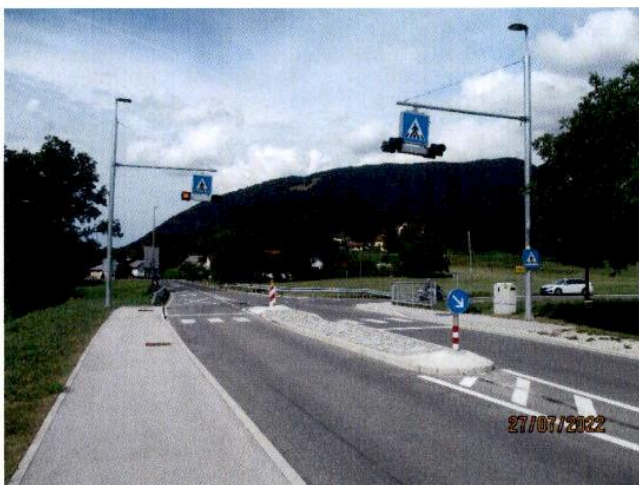
Slika 2: Obravnavani prehod za pešce (pogled v smeri Frankolovega)
