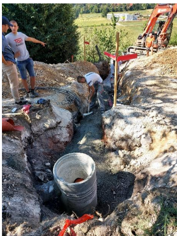
Sliki 14 in 15: Dela na sekundarni fekalni kanalizaciji – sklop 6
