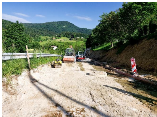
Sliki 10 in 11: Dela na sekundarni fekalni kanalizaciji – sklop 3
