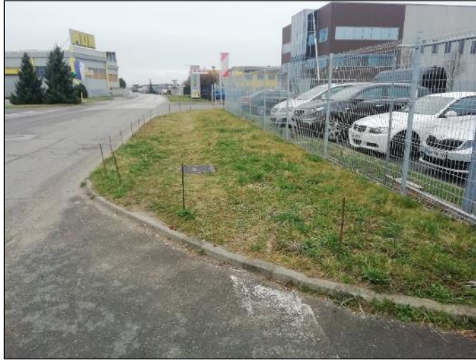
Slika 3-5: Obstoječa JP – bodoče površine za hodnik za pešce v km 0+570
