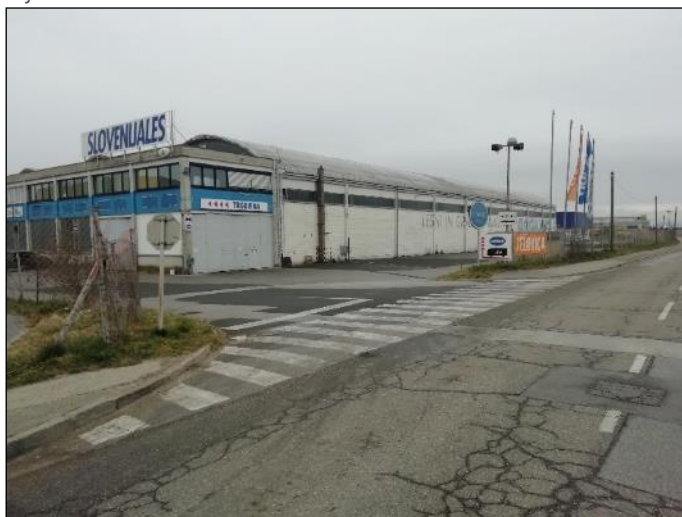
Slika 3-3: Obstoječa JP – priključek v km 0+220 levo
