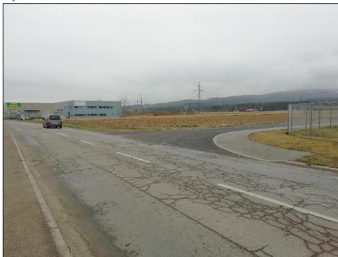
Slika 3-4: Obstoječa JP – priključek v km 0+280 desno
