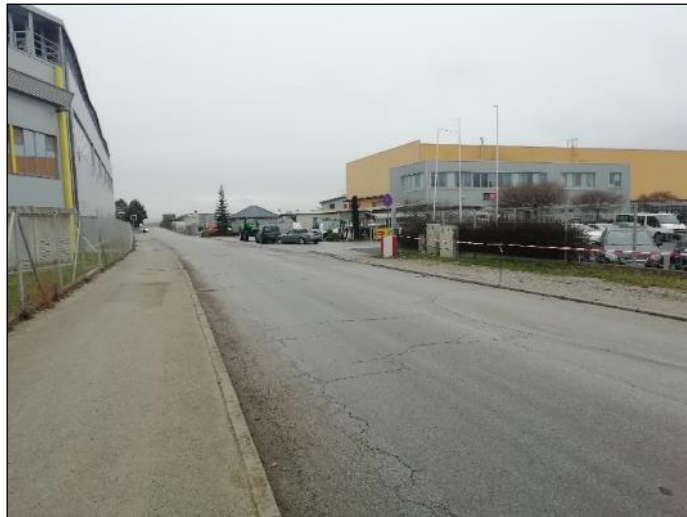
Slika 4-6: Obstoječa JP – pogled iz km 0+680
