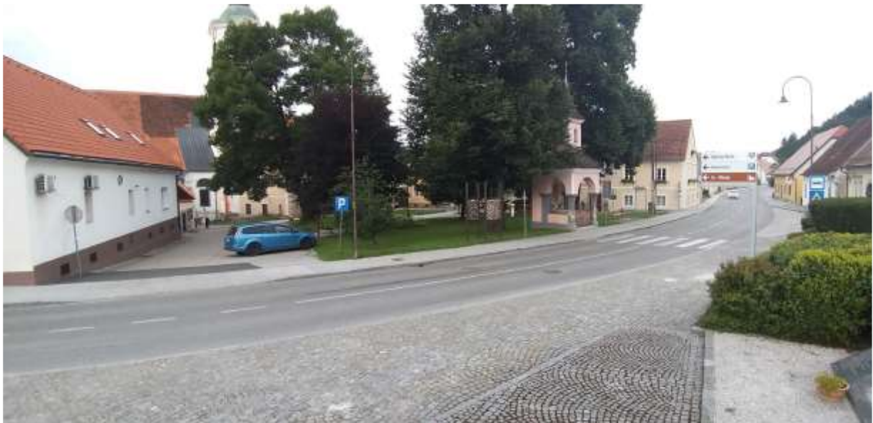
Slika 1: Obstoječe stanje Trga vstaje v Rušah.
