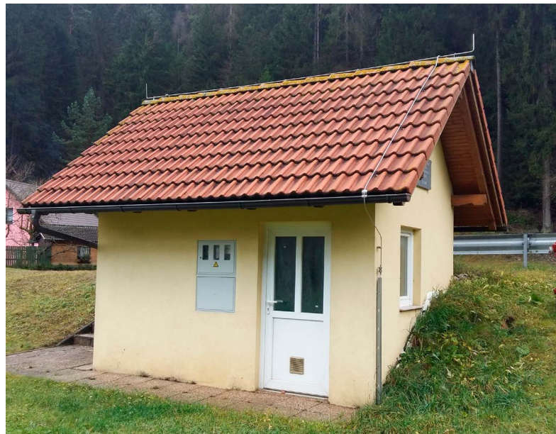
Mala hidroelektrarna v Suhem dolu
