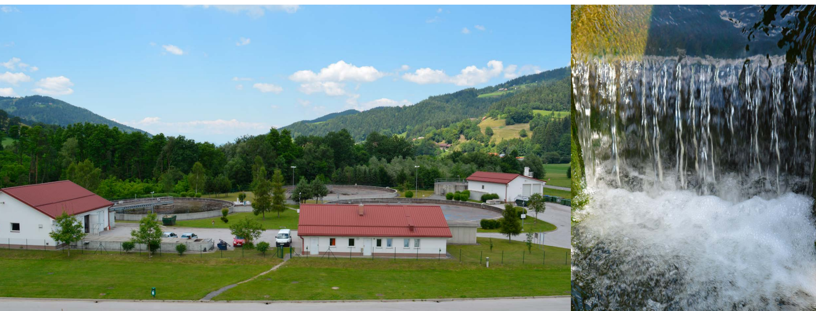
Centralna čistilna naprava Slovenj Gradec (levo); izpust iz naprave (desno)
