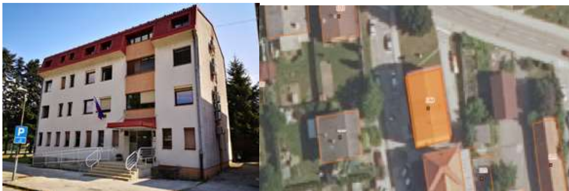
Slika 11.10: Objekt Upravna enota Ruše in njegova mikrolokacija
