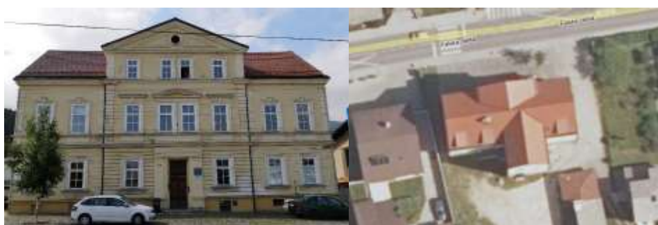
Slika 11.6: Objekt Športni park Ruše - bazen in njegova mikrolokacija
