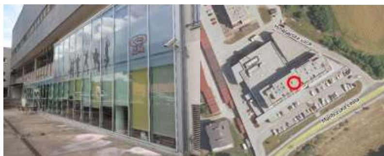
Slika 11.7: Objekt CEZAM Ruše in njegova mikrolokacija
