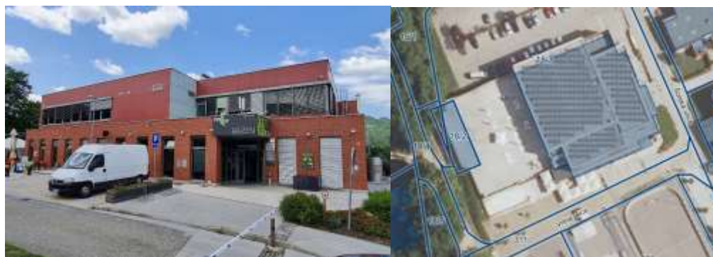
Slika 11.1: Objekt Športni park Ruše - bazen in njegova mikrolokacija
