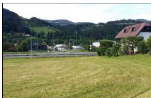
Slika: Območje 3. etape 1. faze ceste – vzhodna stran (pogled proti novemu krožnemu križišču)
