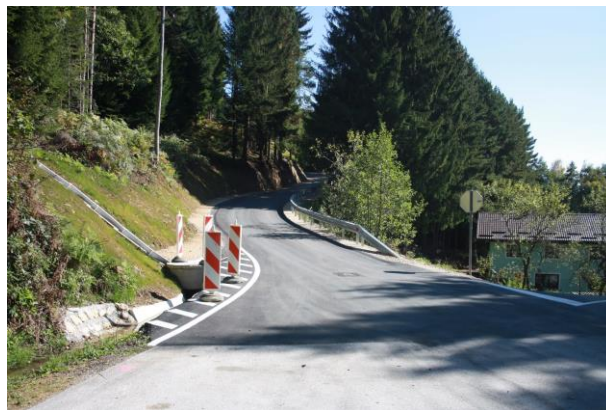
Slika 27: Modernizacija LC 440251 Oplotnica-Božje-Koroška vas
