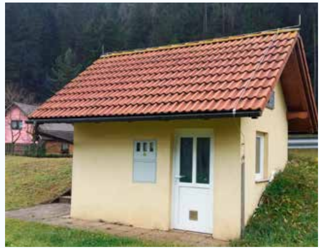
Mala hidroelektrarna v Suhem dolu
