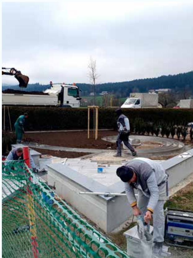
Izgradnja prostora za raztros pepela
