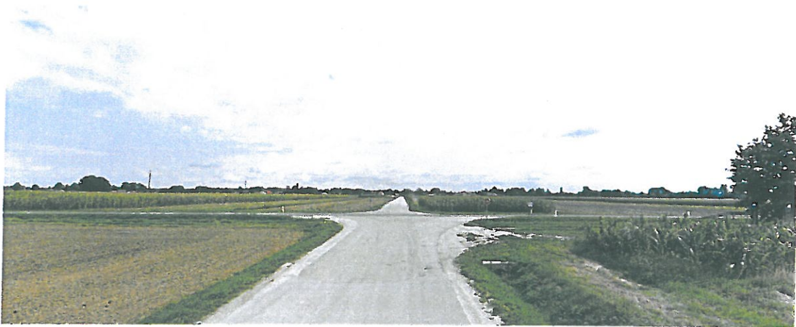
Trenutni izgled križišča - nedokončan asfalt.
