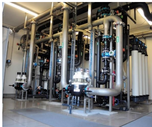
Vodarna Virje z ultra filtracijskimi enotami
