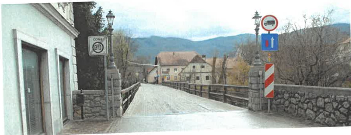
Slika 8: Pogled na iztek južnega mostu na otoku
