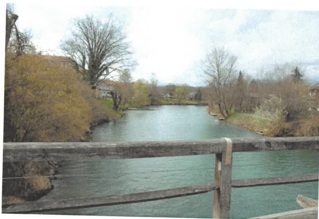
Slika 6: Pogled na reko Krko iz južnega mostu z obrežji dolvodno
