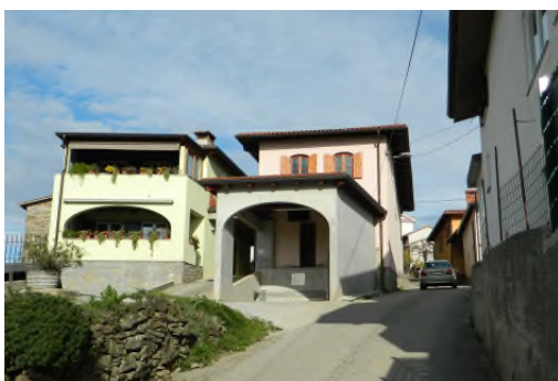
rekonstrukcija in novogradnja stavbe Šlovrenc 10 – pogled z juga
