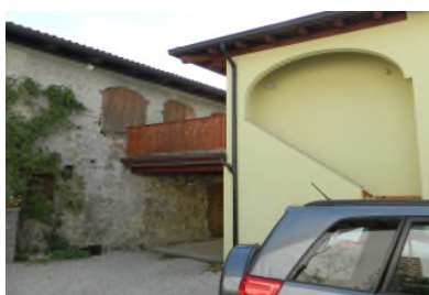
obnovljene okenske odprtine in uporaba ločnega zaključka enake oblike pri novogradnji, stavba Šlovrenc 10 – notranje dvorišče
