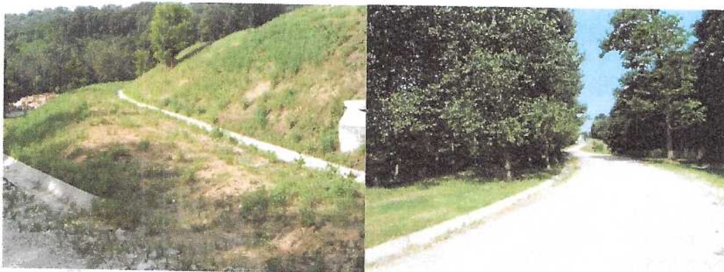
Slika: Sistem betonskih kinet za zajem padavinskih vod
