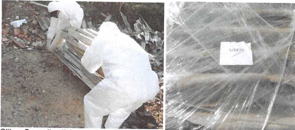
Slika: Sanacija divjega odlagališča azbestno cementnih odpadkov ter pravilno zavita paleta z azbestnimi odpadki
