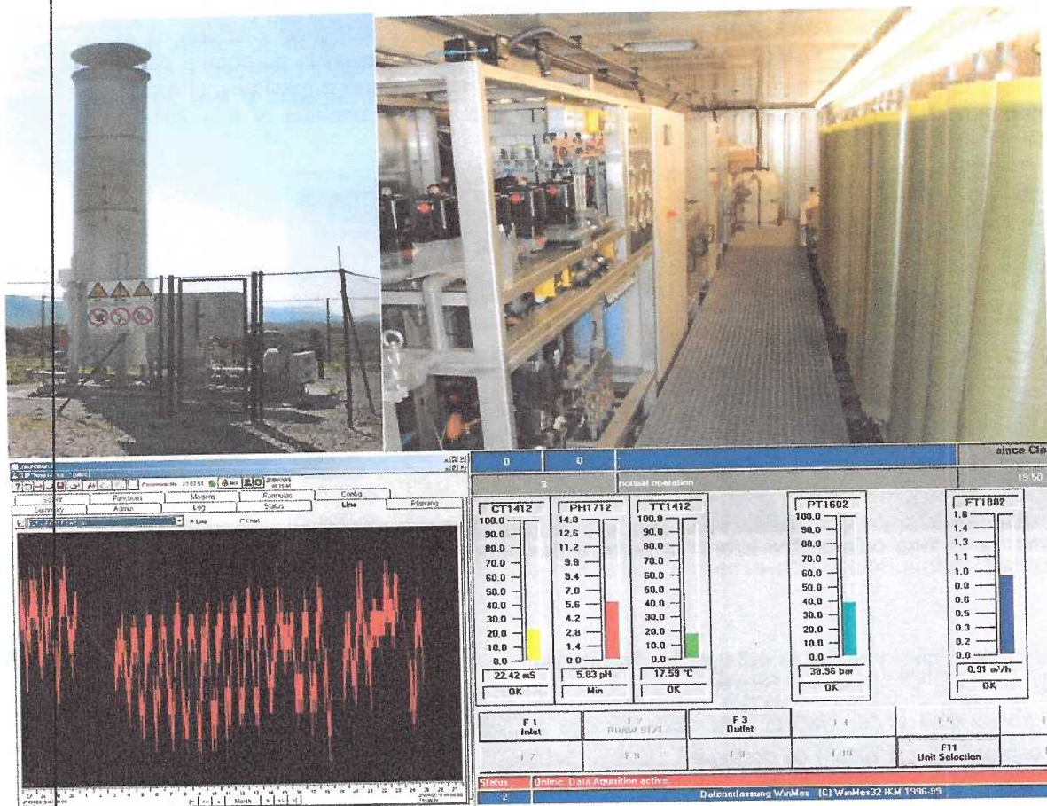
Slika: Bakla za sežig odlagališčnega plina in čistilna naprava na princip reverzne osmoze
