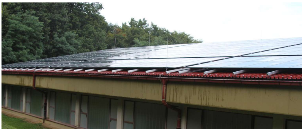
Slika 2: Primer dobre prakse postavitve sončne elektrarne moči 97,02 KW na strehi Osnovne šole Ivana Cankarja v Ljutomeru
