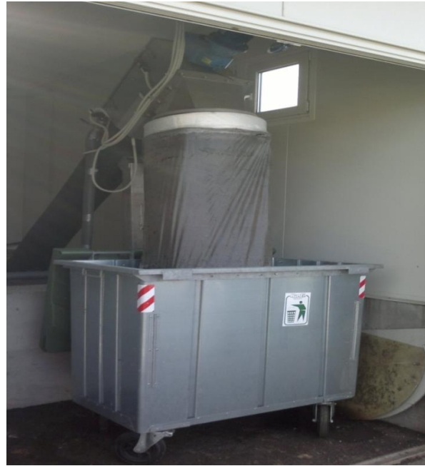
Slika 7: ostanki na grabljah in sitih na KČN Trebnje Slika 8: ostanki na situ KČN Veliki Gaber (19 08 01)
