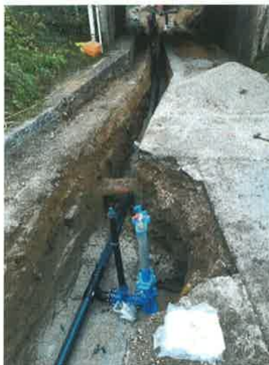
Vgradnja blatnika pred železniškim podvozom v Goričici
