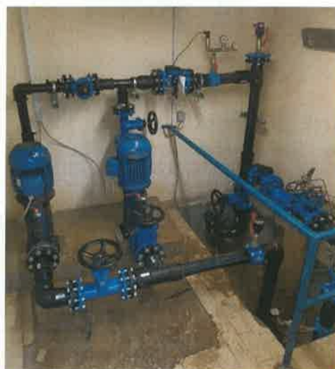
Prečrpališče po predelavi strojnih inštalacij
