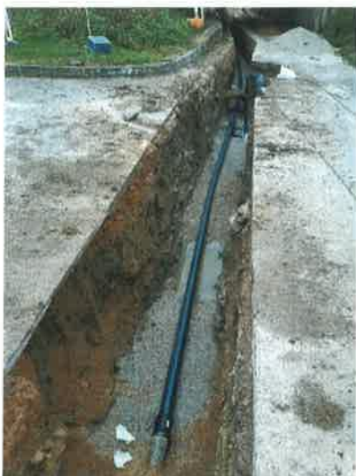
Vgradnja sekundarnega cevovoda Goričica
