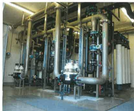
Vodarna Virje z ultra filtracijskimi enotami
