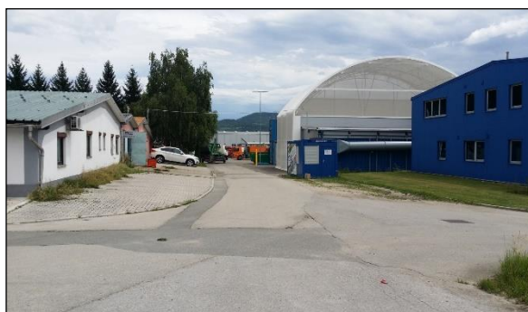
Slika 2: Dokončanje glavne ceste C vključno z padavinsko in komunalno kanalizacijo ter javno razsvetlavo
