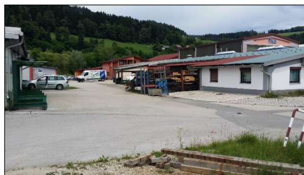
Slika 3: Obnova interne dovozne ceste z izvedbo kanalizacije
