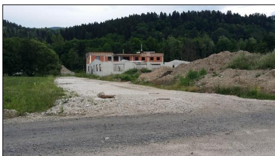
Slika 8: Dokončanje dela dovozne ceste J
