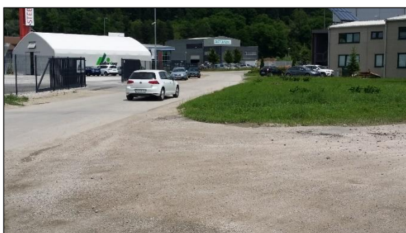
Slika 6: Gradnja parkirišča in obnova ceste B
