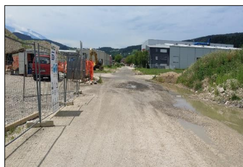
Slika 7: Dokončanje ceste A – vzhodna stran
