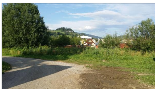
Slika 9: Podaljšanje ceste A in gradnja AB prepusta na potoku
