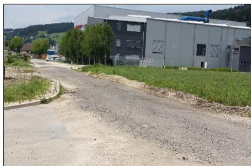
Slika 5: Dokončanje ceste A – zahodna stran
