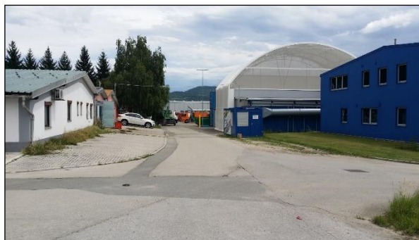
Slika: Dokončanje glavne ceste C vključno z padavinsko in komunalno kanalizacijo ter javno razsvetljava
