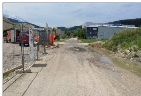
Slika: Dokončanje ceste A – vzhodna stran
