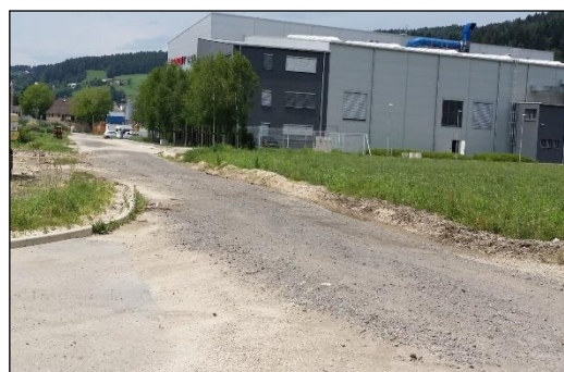
Slika: Dokončanje ceste A – zahodna stran
