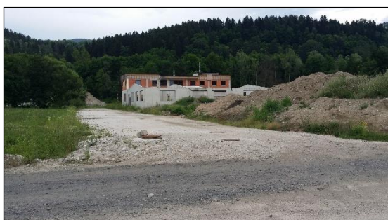
Slika: Dokončanje dela dovozne ceste J
