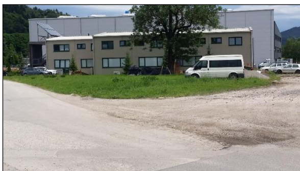
Slika: Gradnja parkirišča za osebna vozila
