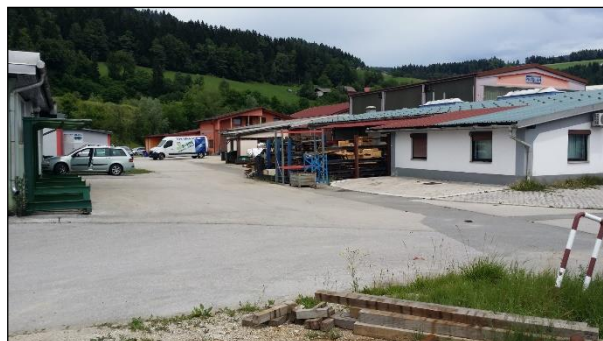
Slika: Obnova interne dovozne ceste z izvedbo kanalizacije
