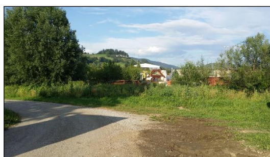
Slika: Podaljšanje ceste A in gradnja AB prepusta na potoku
