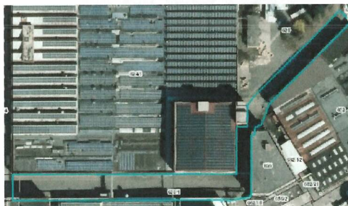
Parcela v naravi predstavlja povezovalno cesto znotraj kompleksa.
