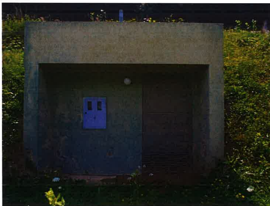
Slika 3-2 Primer objekta brez ograje
