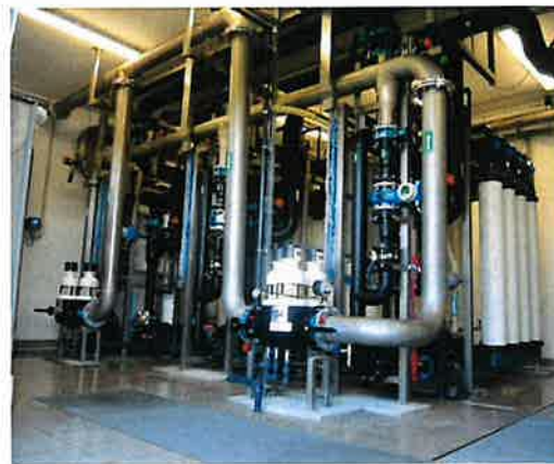
Vodarna Virje z ultra filtracijskimi enotami
