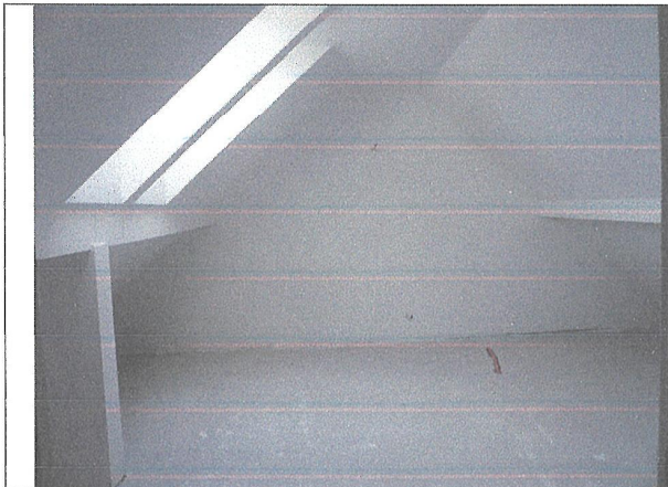
Podstrešje – gradbeno stanje.
