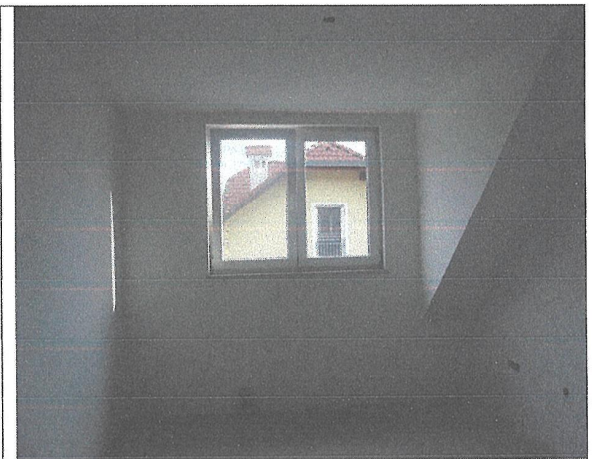
Mansardna etaža – gradbeno stanje.
