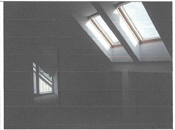
Podstrešje – gradbeno stanje.
