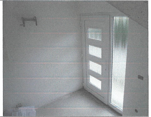
Pritlična etaža – gradbeno stanje.
