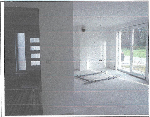
Pritlična etaža – gradbeno stanje.
