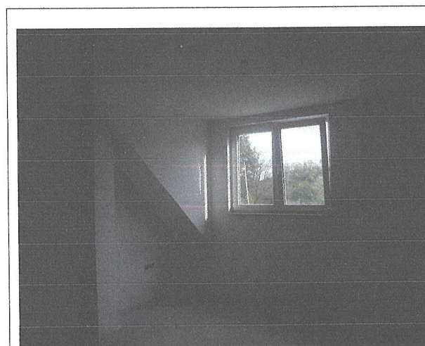
Mansardna etaža – gradbeno stanje.
