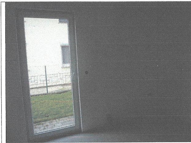
Pritlična etaža – gradbeno stanje.
