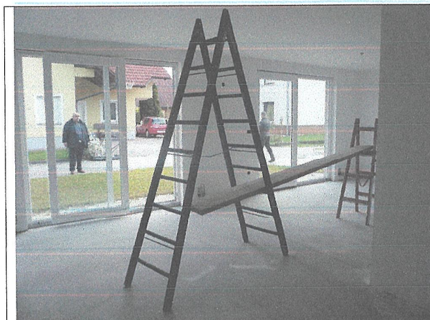
Pritlična etaža – gradbeno stanje.
