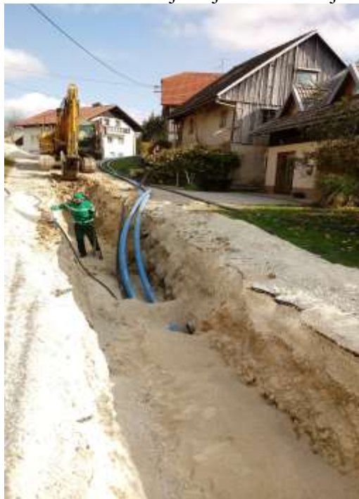
Slika: Obnova vodovoda Travnik (Bela voda)
