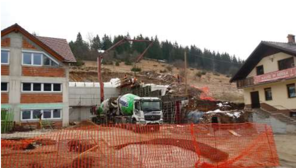
Slika: Izgradnja večnamenskega objekta Hrib
