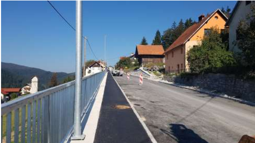
Slika: Obnova regionalne ceste R653/1363 odsek 10,580 km-11,031
