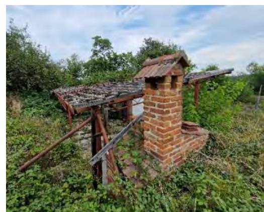
Slika 23: Pogled 7 - obstoječa nadstrešnica
