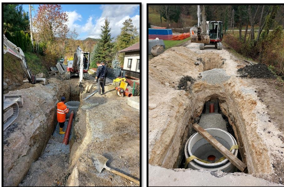
Sliki 6 in 7: dela na kanalizaciji Vidner - Osredek
