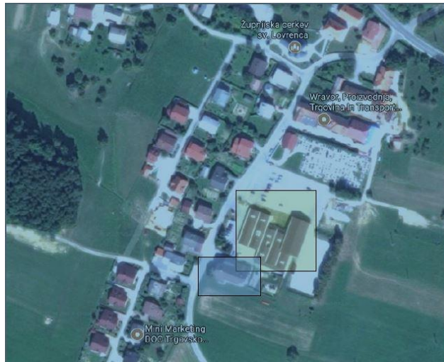
Slika 12: Območje izgradnje kotlovnice
