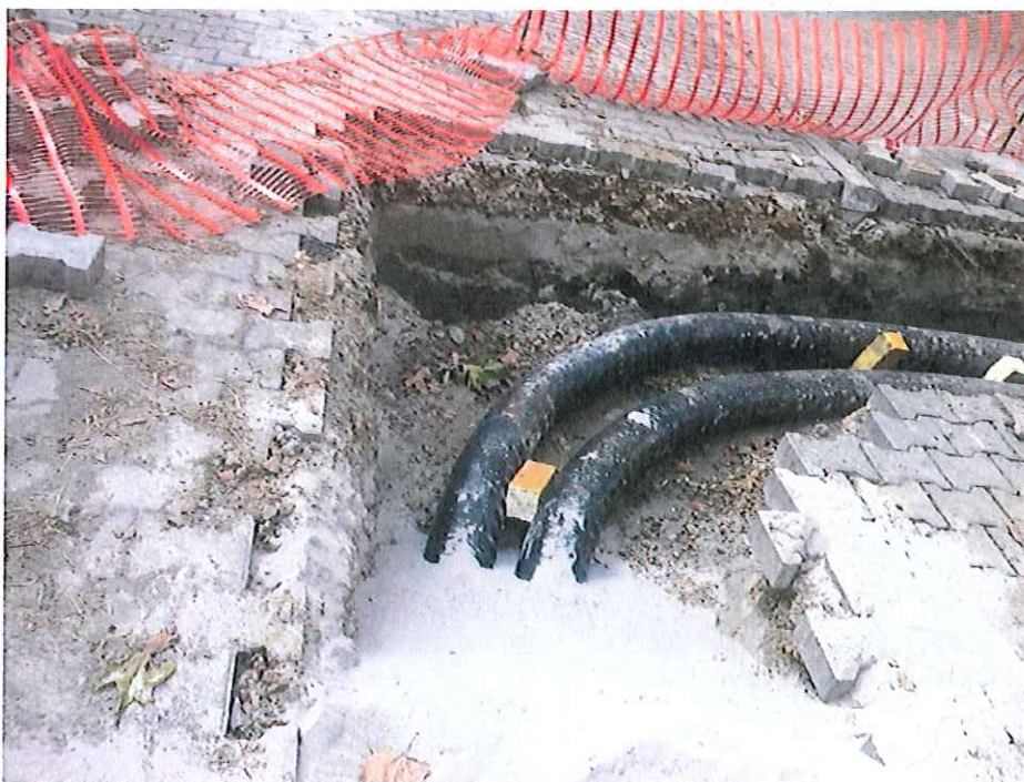
Slika 10: Prikaz polaganja cevodov v krivinah
