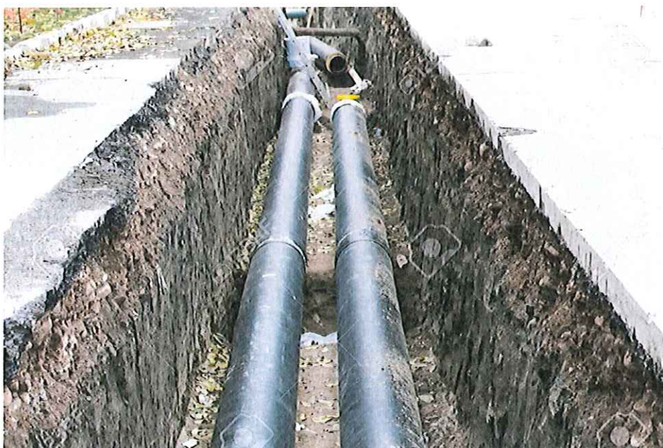
Slika 8: Slika polaganja predizuliranih cevi
