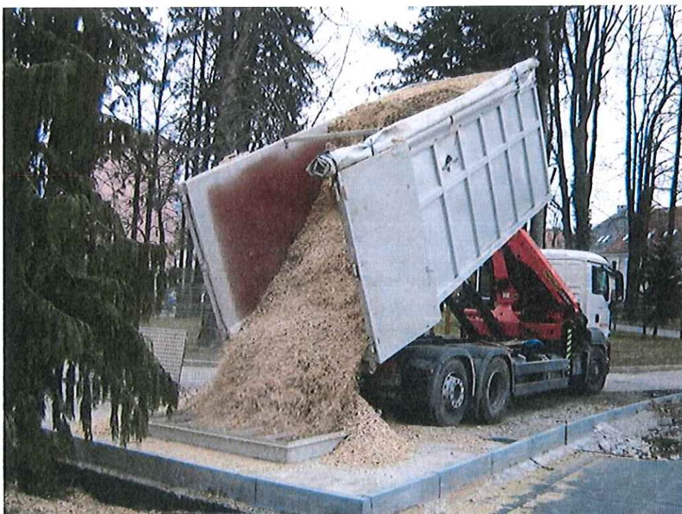
Slika 5: Vsipavanje lesnih sekancev v skladišče pod nivojem terena
