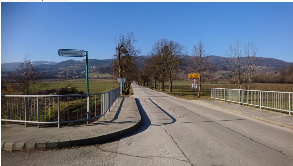
Slika 4-4: Prehod preko mostu
