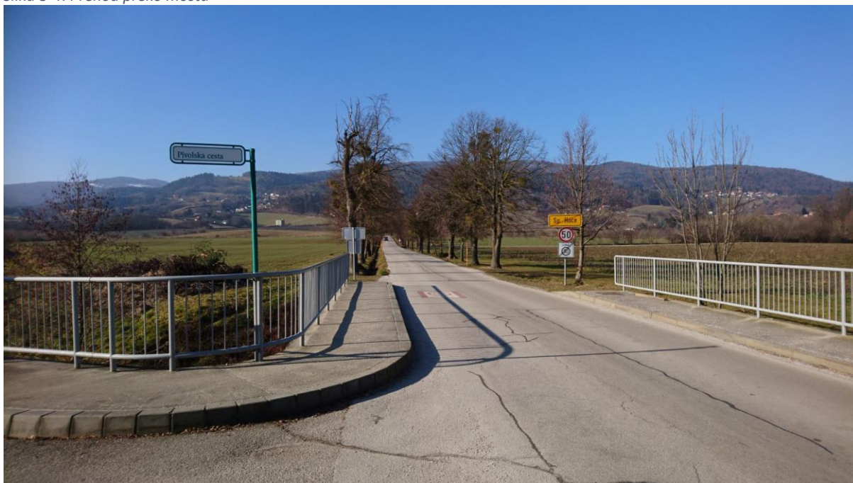
Slika 3-4: Prehod preko mostu
