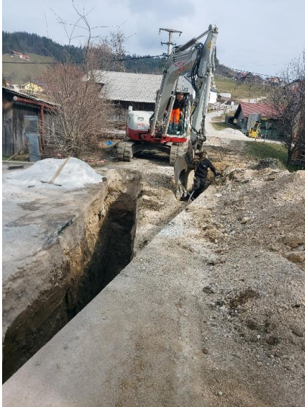
Sliki 5 in 6: Izgradnja kanalu S14 in zaključek del na kanala S13
