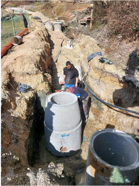
Sliki 7 in 8: Izgradnja kanala S4
