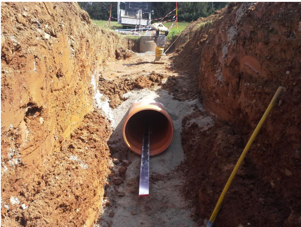
Slika 18: Izdelava kanalizacije Lepovče
