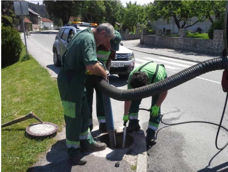
Slika 13: Čiščenje fekalne kanalizacije
