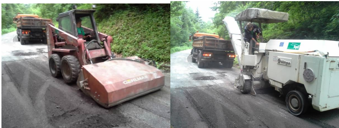
Slika 17: Rezanje in krpanje cest z asfaltom
