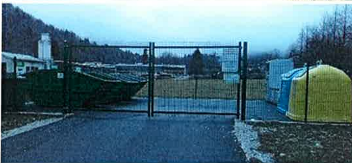
Slika: Zbirni center Anhovo in ZBC Čepovan
