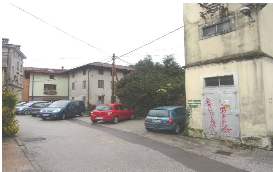
Slika 28: Prikaz parkirišča pri trafo postaji
