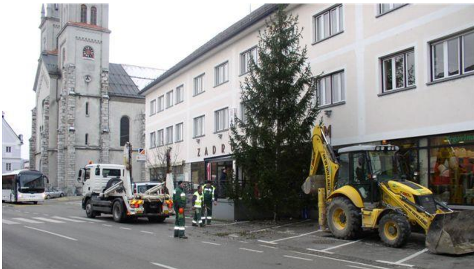
Slika 16: postavljanje novoletne jelke v centru Ribnice
