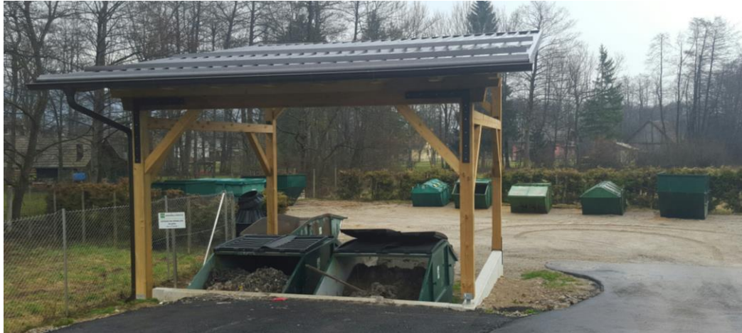
Slika 7: Zabojniki za začasno skladiščenje odpadkov iz grabelj, sit in peskolova
