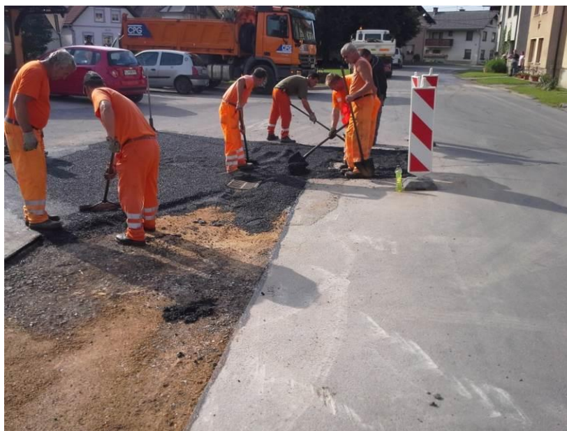
Slika 18: Krpanje cest z asfaltom
