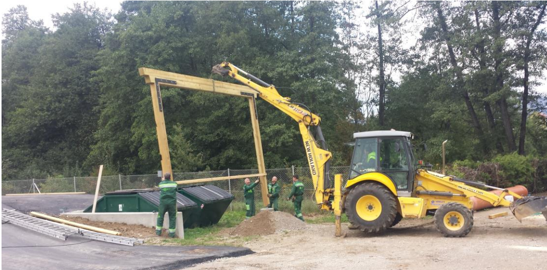
Slika 19: Postavljanje nadstreška na ČN Ribnica
