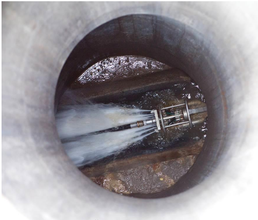
Slika 12: Čiščenje fekalne kanalizacije
