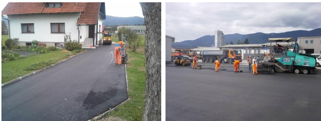
Slika 22: Asfaltiranje dvorišč
