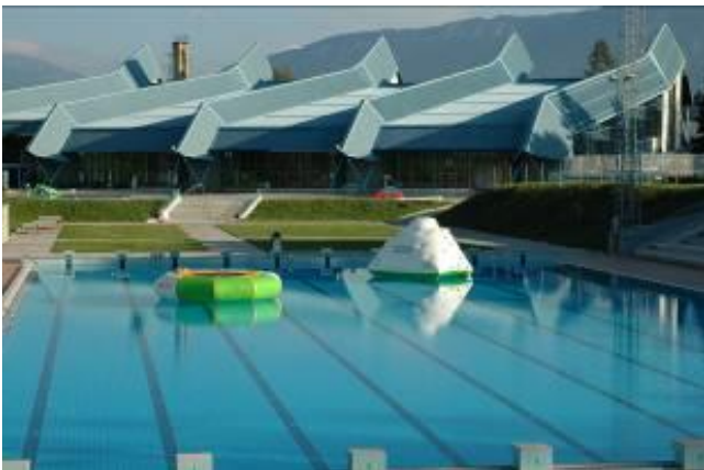
Foto 7.25. Letno kopališče Kranj
