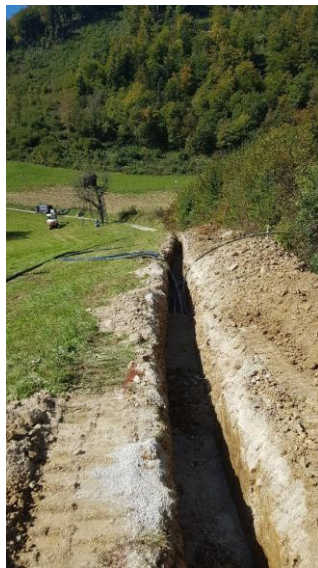
Slika 11: Zamenjava vodovodne cevi rezervoar Kovač (Krneg) – črpališče Grobovi
