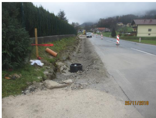
Slika 6: Izgradnja hodnika za pešce ob regionalni cesti Stranice – Višnja vas
