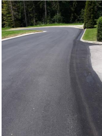
Slika 8: Sanacija odseka na LC 485021 Križevci – Osredki
