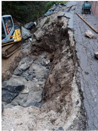
Slika 9: Sanacija usada brežine v Loški gori
