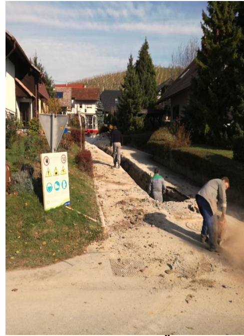
Slika 4: Obnova kanala Škalce
