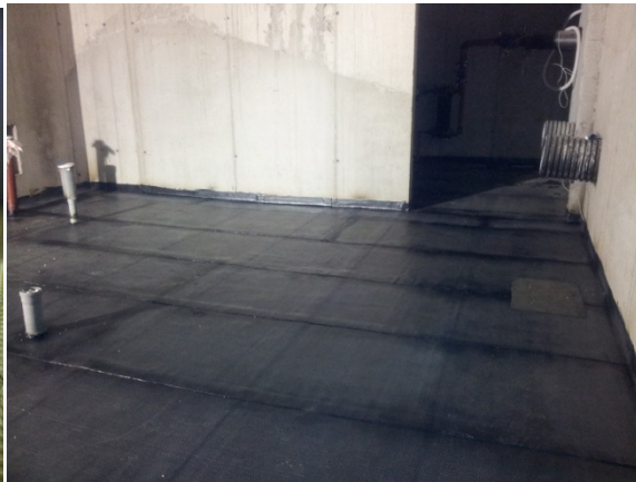
Izvedene horizontalne hidroizolacije in toplotne izolacije v vseh etažah vključno z estrihi in celotni talnim gretjem
