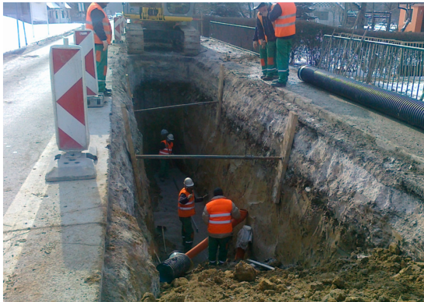
Slika 6: Kanalizacija Nova Dobrava 3
