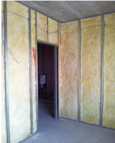
Izvedena montaža suhomontažnih pregradnih sten
