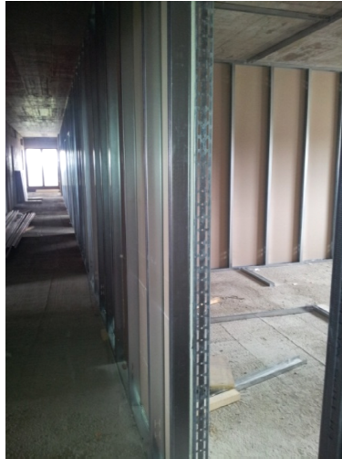
Izvedena montaža suhomontažnih pregradnih sten
