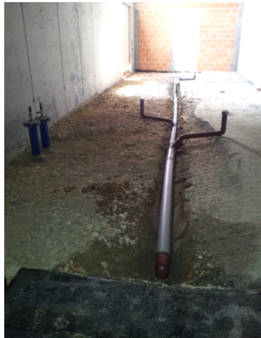
Dokončana vsa kanalizacija pod nivojem podložnega betona
