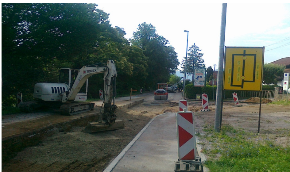
Slika 4: Kanalizacija Nova Dobrava 2
