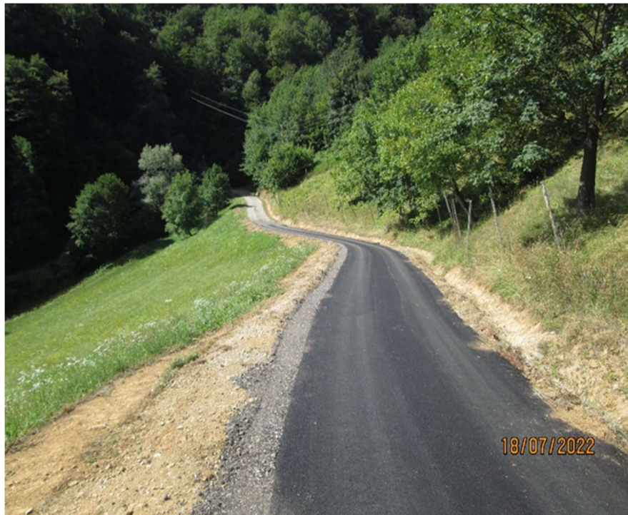
Slika 14: Asfaltiranje ceste Zveličarjev breg II. faza
