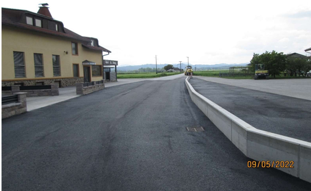
Slika 12: Izgradnja ceste v Pobrežju
