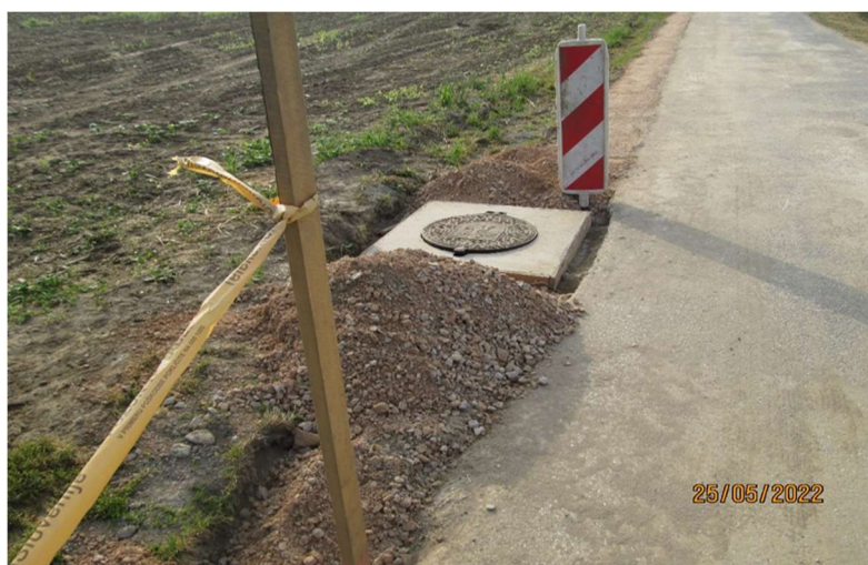
Slika 3: Izgradnja kanalizacije v Šturmovcih
