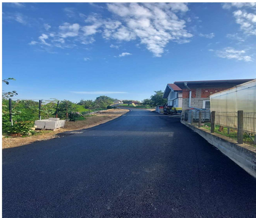
Slika 13: Modernizacija odseka ceste v Veliki Varnici
