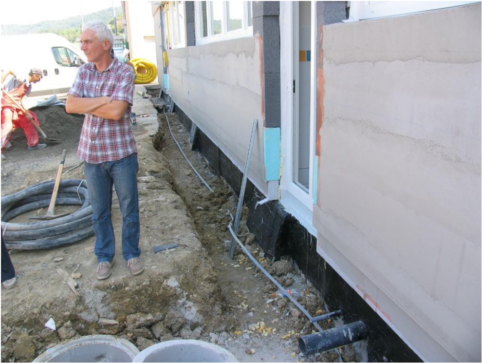
Nova hidroizolacija in toplotna izolacija temeljev.
