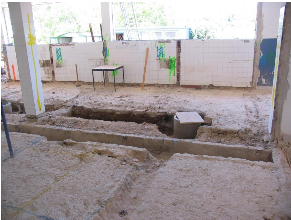
Ponovno urejanje odpadne kanalizacije v objektu.
