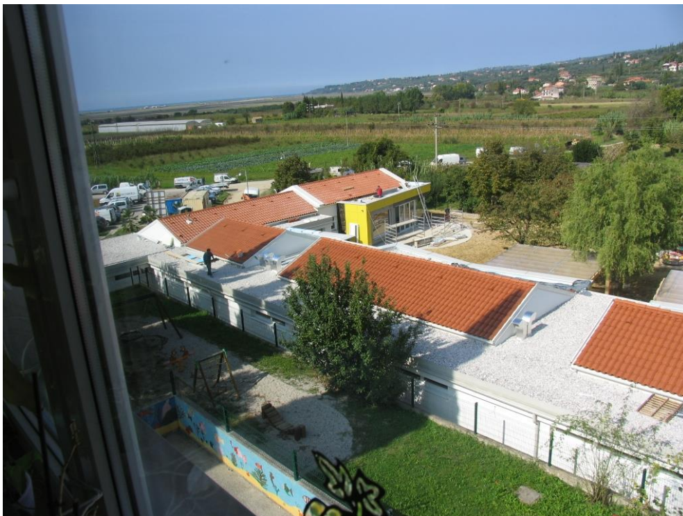
Pogled iz višine na končani vrtec.
