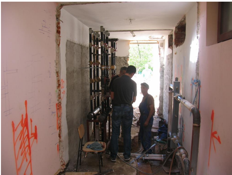
Razpeljava instalacijskih vodov ogrevanja.
