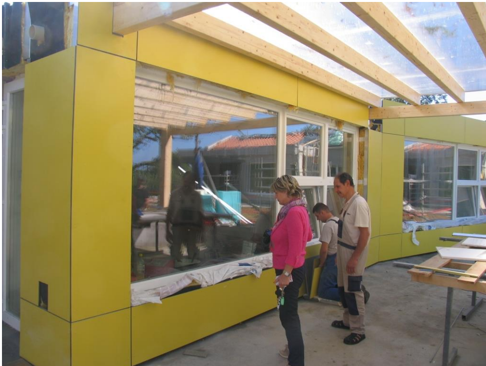
Nova Esal fasada prizidav in dozidave vrtca.
