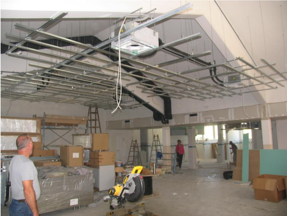
Nosilna konstrukcija obešenih elementov stropov in konvektorjev.
