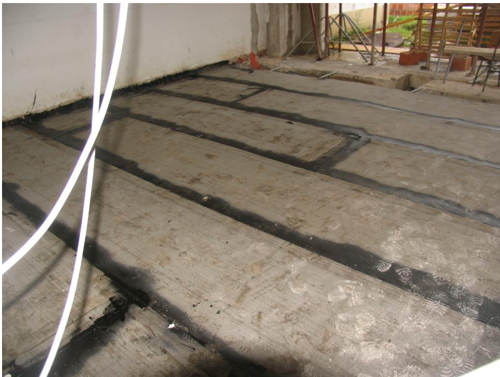
Nova hidroizolacija.
