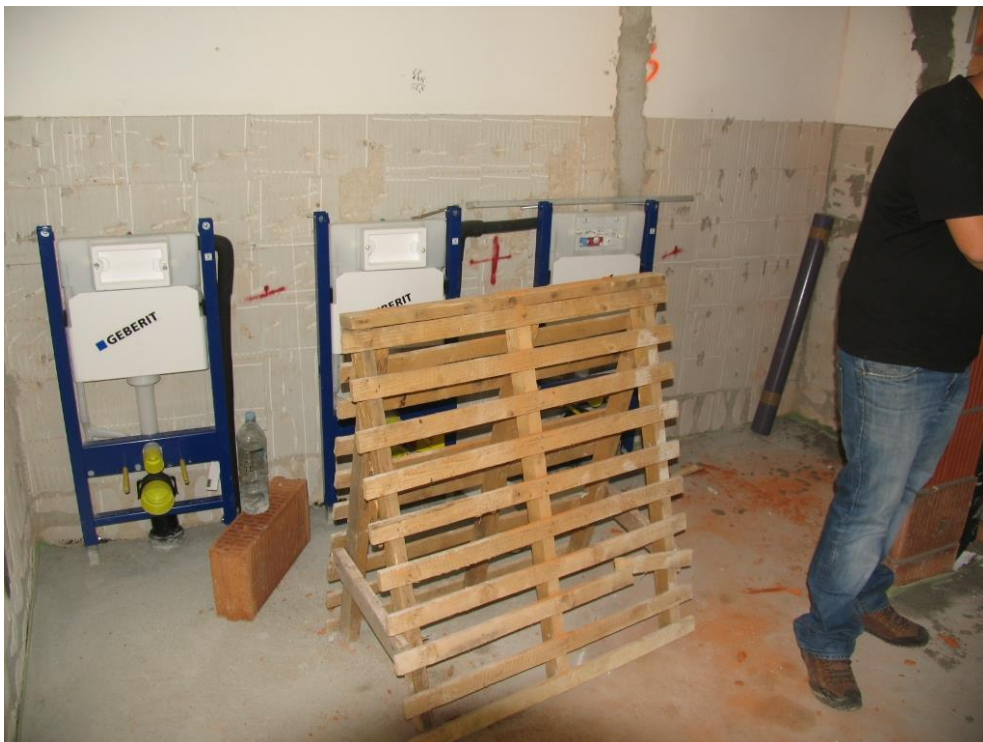
Montaža sanitarne opreme in elementov prezračevanja in ogrevanja.
