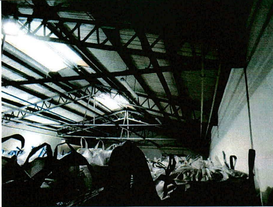
7. Vidna nosilna konstrukcija ostrešja južne ladje kompleksa je v dobrem stanju
