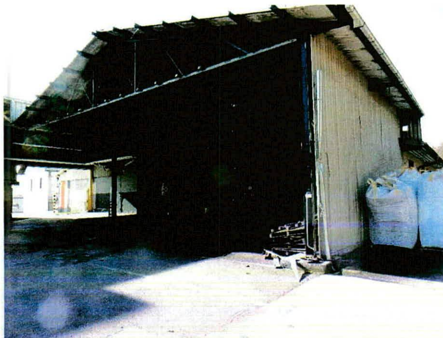
6. Novejši nadstrešek v SV vogalu objekta se v sklopu rekonstrukcije ruši
