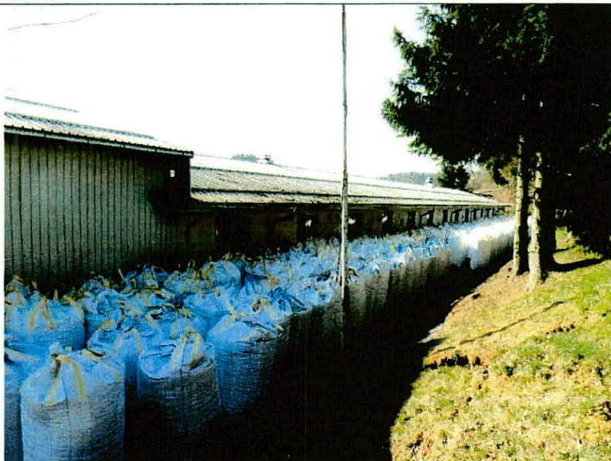
4. Severna fasada objekta
