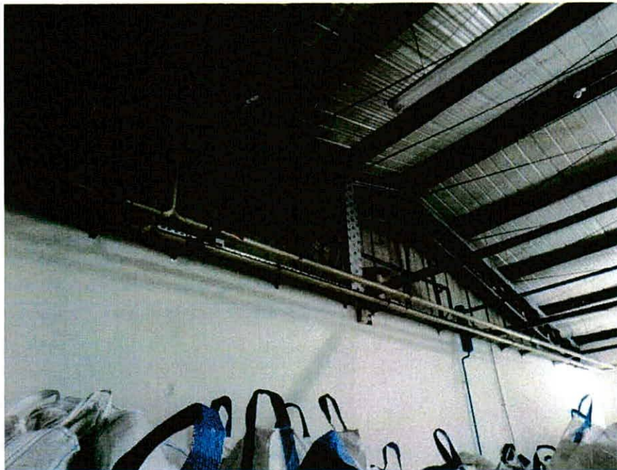
8. Krajni primarni strešni nosilec ob vzhodnem zatrepnem zidu južne ladje
