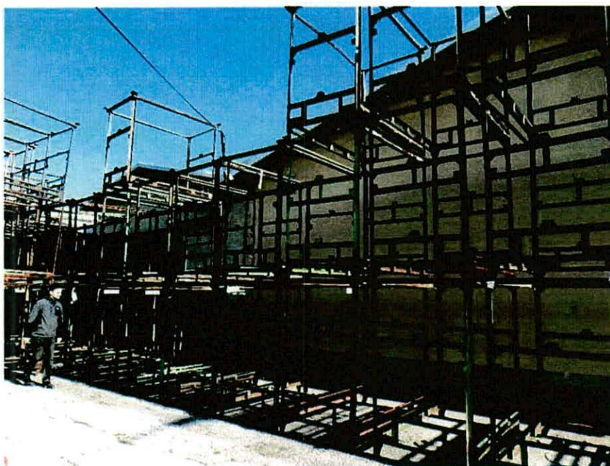
5. Zahodna fasada objekta
