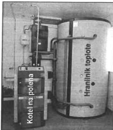
Slika 43; Kotel na polena s hranilnikom toplote, ki toploto iz kotla prevzema, ko jo grelna telesa ne porabljajo v celoti (Vir: www.baudochselbst.com )
