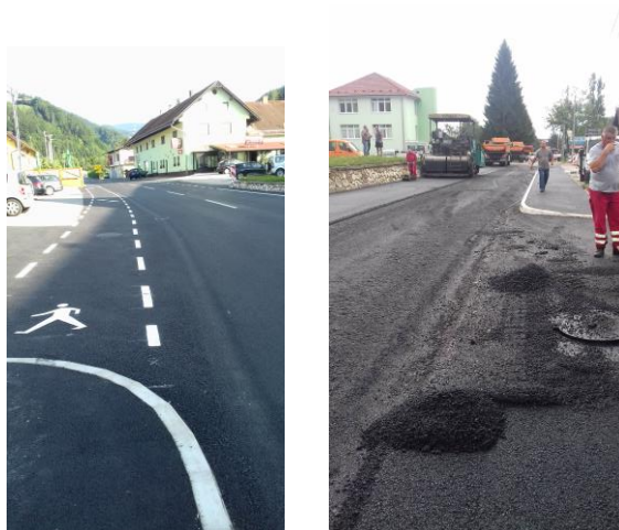
Sliki 13 in 14: Dela na Kovaški cesti
