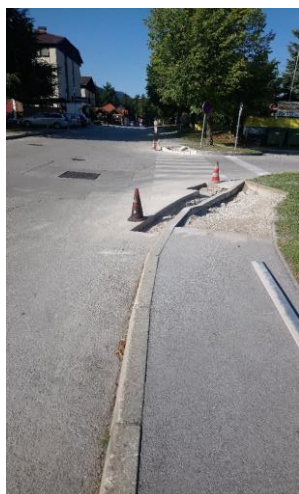
Slika 3: Izvedba del prilagoditev in poglobitev pločnikov
