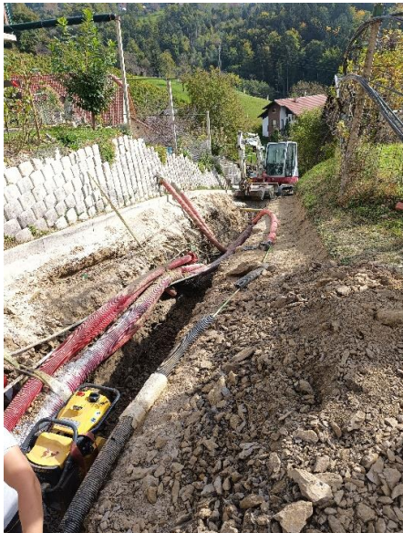
Slika 21: Izgradnja kanala Zlakovška cesta
