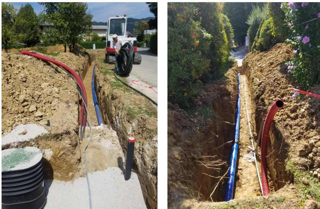
Sliki 26 in 27: Obnova vodovoda in JR v Ulici bratov Mernik
